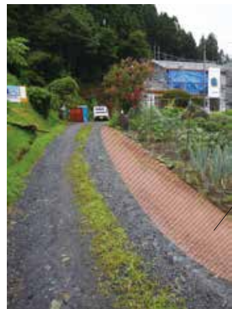
図7 通路を拡幅して重機進入を可能とした事例
