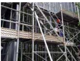
植栽設置（造園工）
