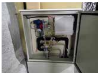
灌水装置設置（設備工）
