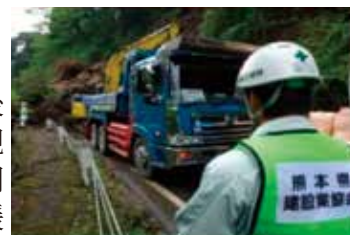
道路啓開（倒木・崩壊土砂の撤去）
