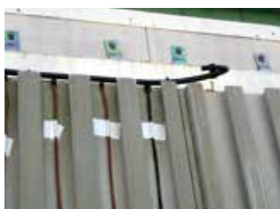
灌水配管（設備工）
