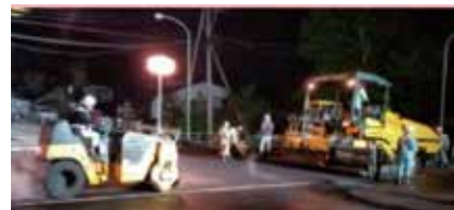
通行不能の交差点での応急工事
