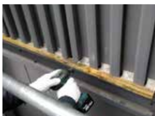
アングル取付（金物工）
