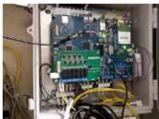
装置内配線（電気工）
