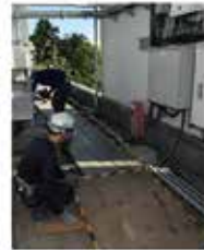
①搬送路の設置
